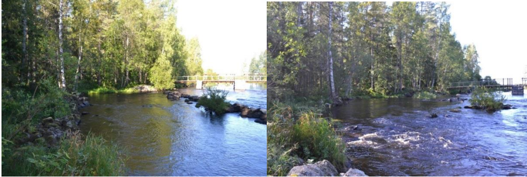
Figur 3: Två stenkistor plockades bort. Lekområde skapades i anslutning till den nya fors-nacken. Uppväxtområde i strandsonen samt i sidofåran innanför brytaren tillgängliggjordes.
