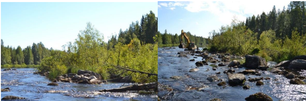
Figur 4: En stenkista avtäcktes från vegetation och stenen placerades ut för att skapa ett grunt uppväxtområde. Strax uppströms detta område ligger det lek område som tidigare år varit mest nyttjat.
