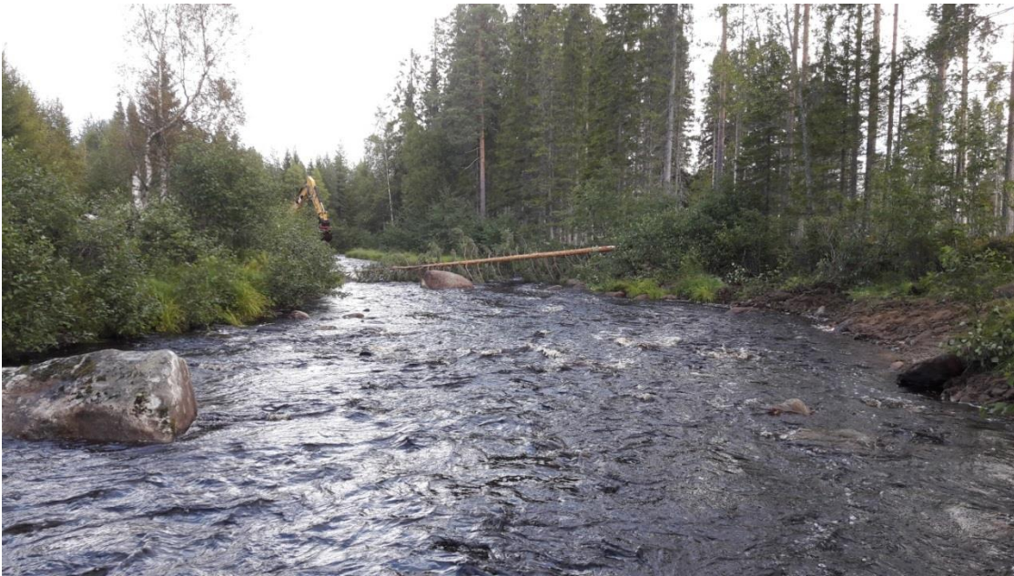
Figur 9: Efter restaurering har sten plockats ut och material i älven omfördelats för att dämna och skapa en bredare älvsfåra med mer variation och större djup.
